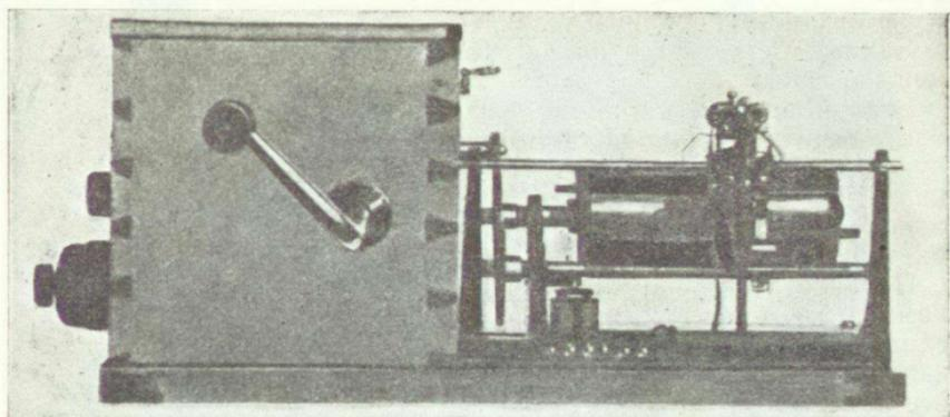
Рис. 5. Один из первых бильдаппаратов (Германия).
