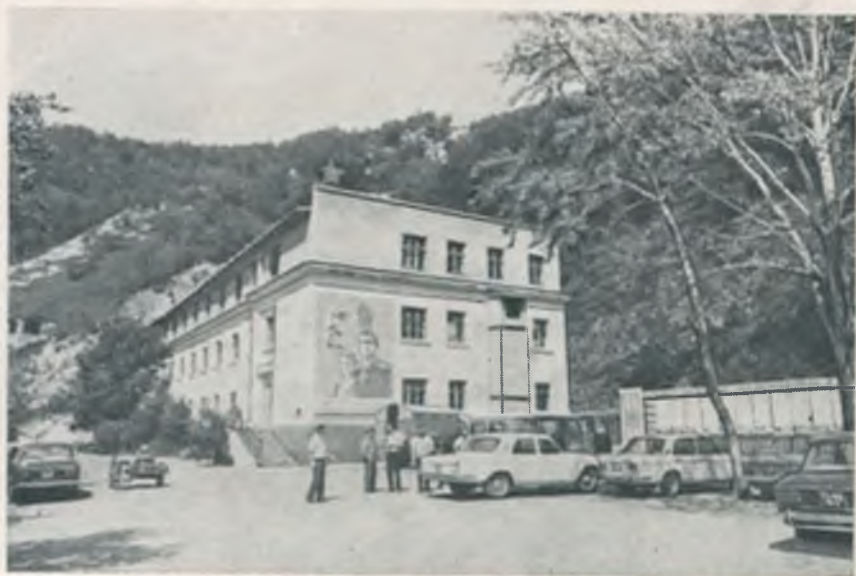
Промплощадка Верхнего рудника
