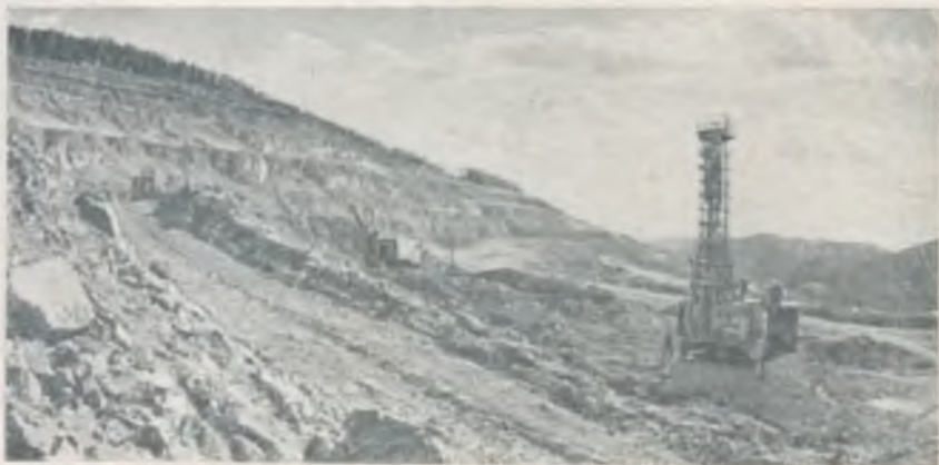
Мощный буровой станок СБШ-250 на карьере При- морского ГОК
