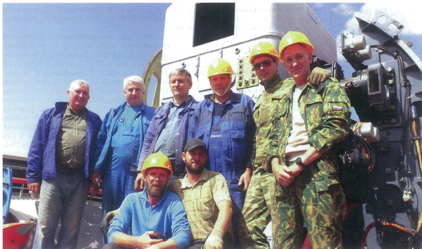
Монтаж доработанных входных устройств
