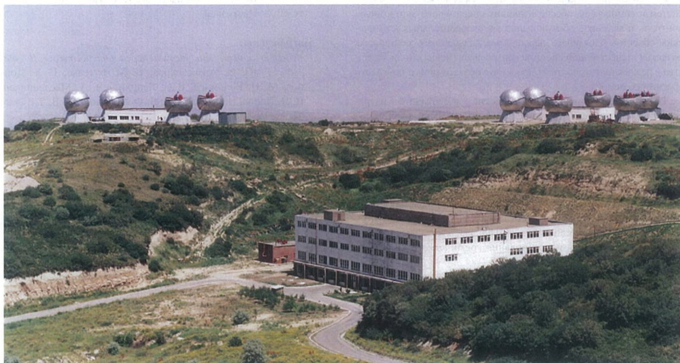
Комплекс 54Ж6 на объекте
