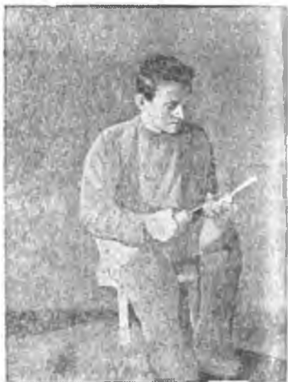
Рис. 37. Вырезывание лунки ложки (прием с конца лопасти).
