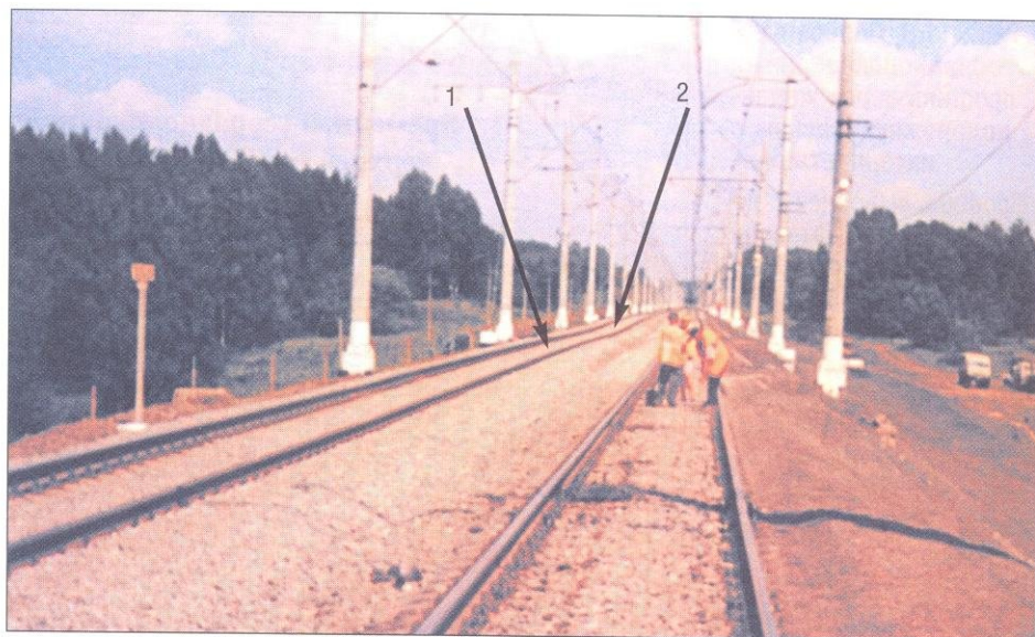
РИС. 11.9. Фото участка высокой ж/д насыпи, где на протяжении длительного времени происходило проседание и вспучивание насыпи.
