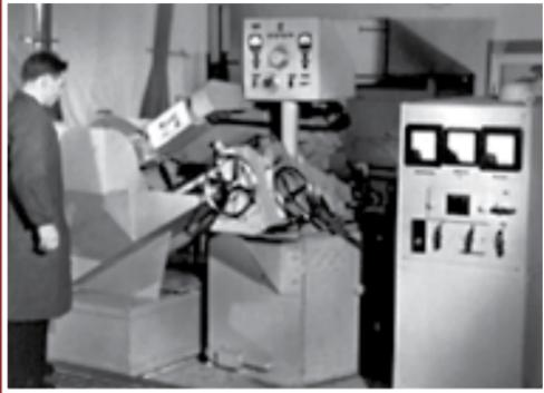
Рис. 9. Экспериментальная установка для разрезания различных материалов движущейся лентой
