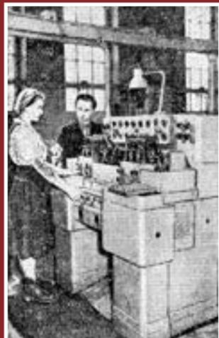
Рис. 183. 8-шпиндельный электроискровой станок для шлифовки корпуса распылителя топливного насоса трактора ДТ-54
