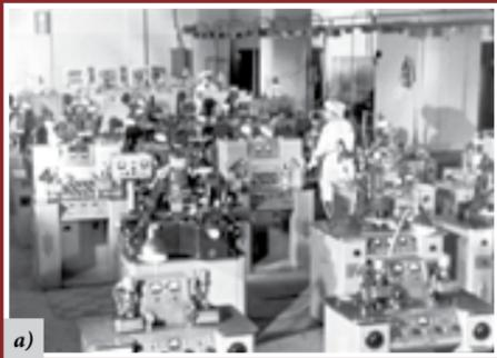
Рис. 203. Электроискровой опытно-производственный участок отдела 62: а) кадр из кинофильма 1961 г., б) после модернизации в 1962 г.
