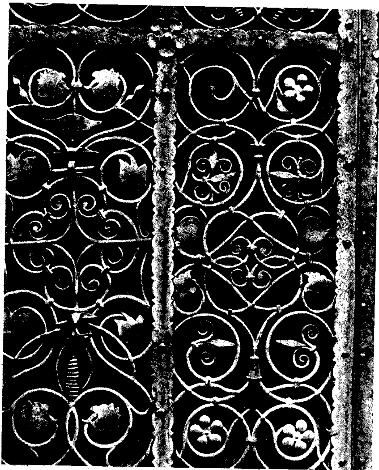
Рис. 53. Оконная решетка в индржиховоградском замке 58
