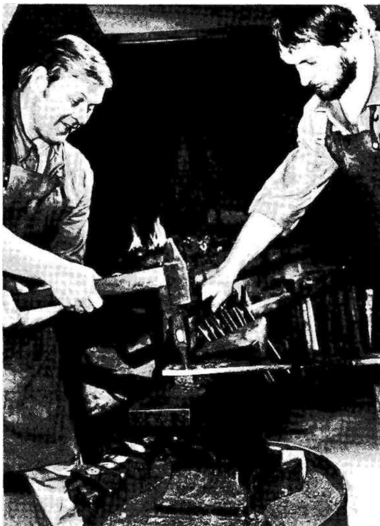
Рис. 250. Рубка заготовки
