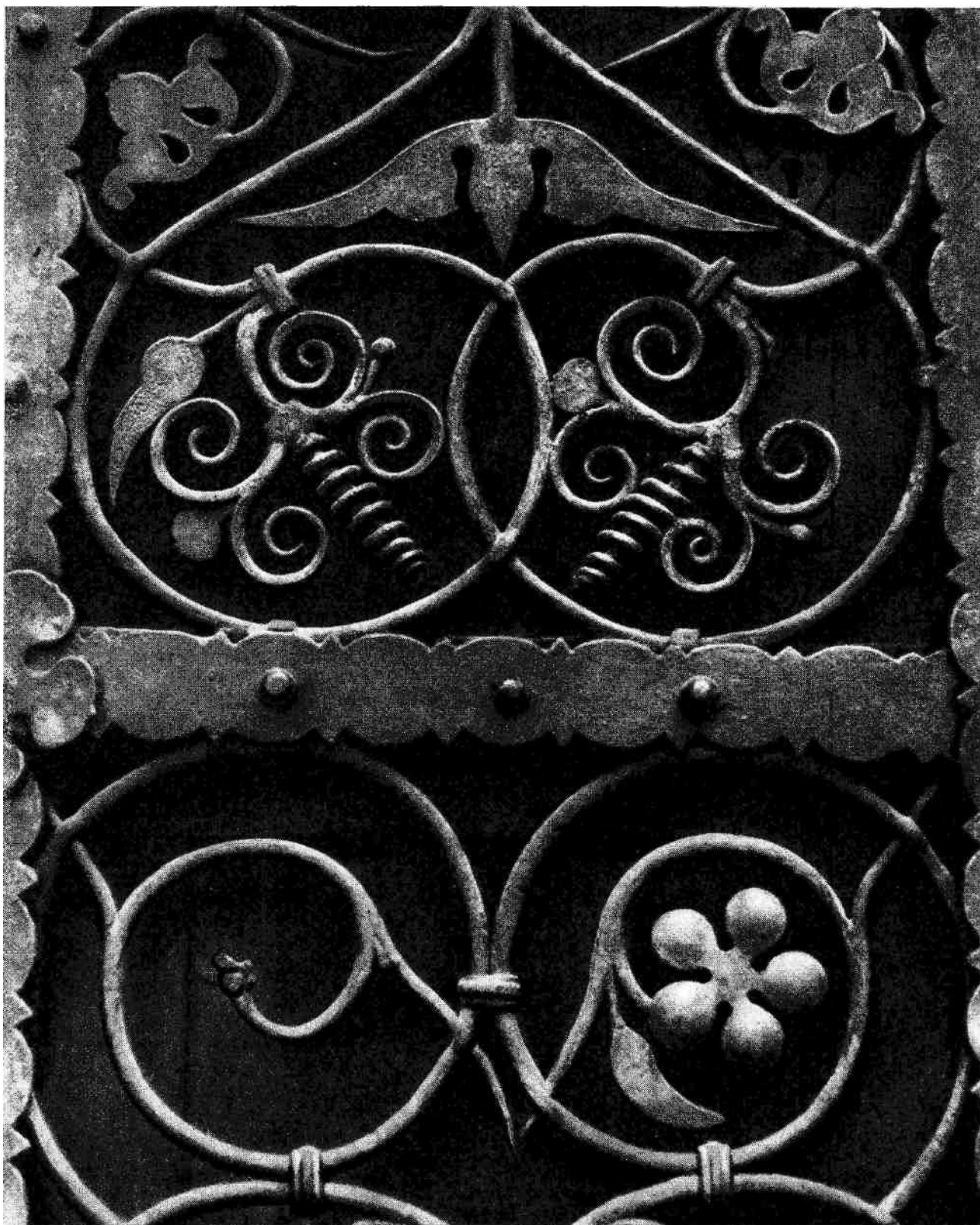
Рис. 54. Оконная решетка в индржиховоградском замке, деталь
