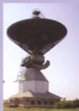
Антенна КТНА-200. Диаметр зеркала 25 м. Работает в дециметровом диапазоне волн. Эффективная площадь 240 м 2 . Разработана в 1965 г.
