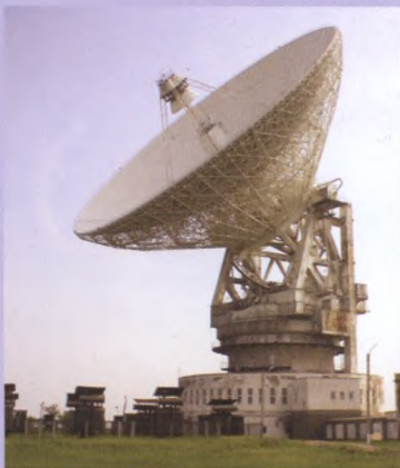
Самая эффективная в мире, многофункциональная, полуполупроводниковая антенна П-2500. Диаметр главного зеркала – 70 метров. Функции и параметры: - Радиомаяковая станция, в режиме передачи коэффициент усиления – 15000000, излучаемая мощность – 300 кВт, в режиме приема чувствительность 12 дБ. - Обеспечение работы командно-измерительных систем в сантиметровом и дециметровом диапазонах для связи на межпланетных расстояниях. - Обеспечение работы радиолокатора на межпланетных расстояниях в миллиметровом диапазоне волн. - Обеспечение радионавигационных наблюдений на длинах волн 18 см, 1,35 см, 8 мм. Оптимизация Государственной приемной в 1982 году.
