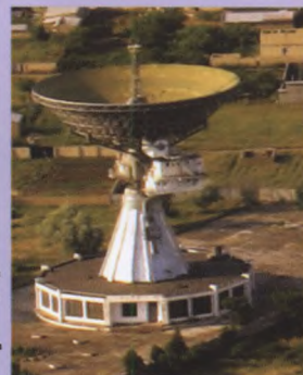
Антенна П-4001. Диаметр зеркала 32 м. Назначение: передача команд, управление на межпланетные космические аппараты. Эффективная площадь 370 м 2 в дециметровом и 340 м 2 в сантиметровом диапазонах волн. Разработана в 1973 г.
