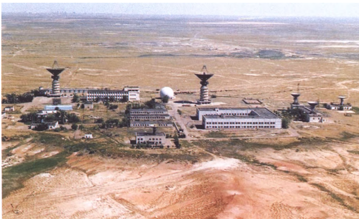
Командно-измерительная система «Сатурн-МС» (КИП-1), космодром Байконур. Обеспечивала работу орбитальных пилотируемых КА «Союз», «Союз-Т», «Прогресс» и лунных КА ЛОК и ЛК. Диапазон частот – 770/920 МГц. Год разработки – 1963
