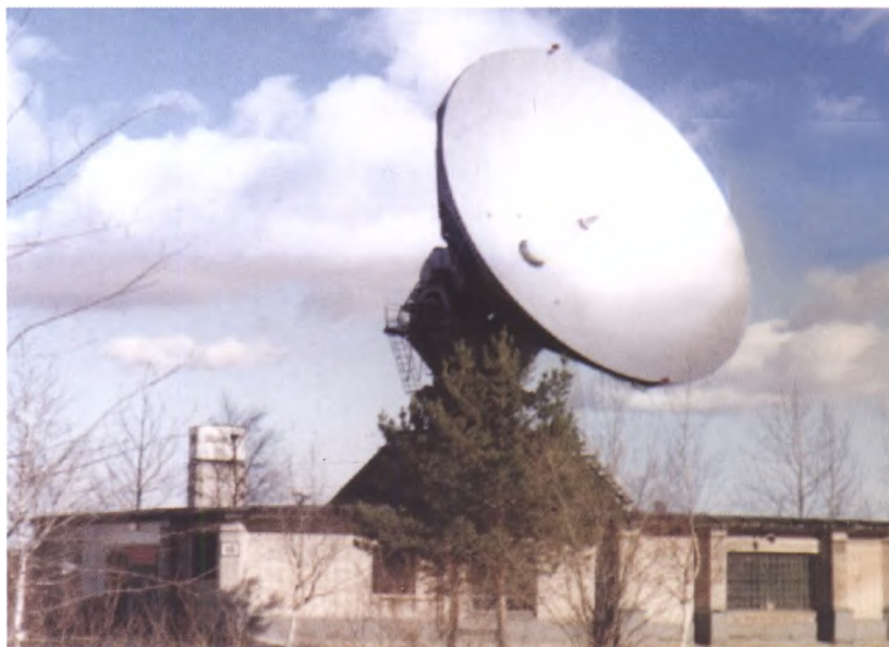
Командно-измерительная система Ку –диапазона (КИП-14). Обеспечивает работу КА «Глонасс», «Молния», «Гейзер» Год разработки – 1970
