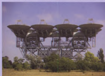
Антенна АДУ 1000. Сборка из 8 зеркал диаметром 16 м каждое. Первая антенна для работы с межпланетными космическими аппаратами. Работает в дециметровом диапазоне волн. Эффективная площадь 6700 м 2 . Разработана в шестидесятых годах двадцатого столетия.
