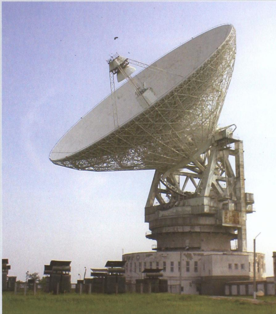
Антенна П-2500 диаметром 70 м.
