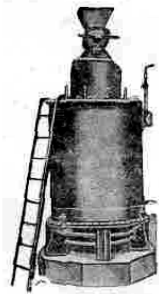
Рис. 62. Генератор Крослей с кольцевой решеткой. Внешний вид.
