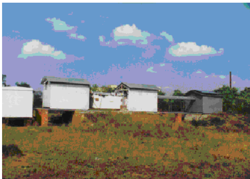
Рис.5.2. Общий вид вагона-кабины с управляющим компьютером, главного павильона Николаевского АМК в раскрытом состоянии, трубы вакуумного коллиматора и дополнительного павильона для автоколлимационного ПЗС микрометра.
