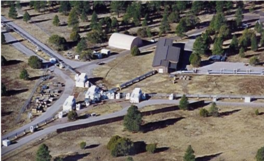
Рис.7.3. Общий вид оптического интерферометра NPOI (Flagstaff, США) (Y-образная база NPOI-II просматривается в виде конструкций из вакуумных труб; справа, вверху – длинное помещение лаборатории для размещения ЛЗ и другой контрольно-измерительной аппаратуры NPOI-II; система сидеростатов NPOI-I просматривается в виде четырех светлых павильонов в центре).
