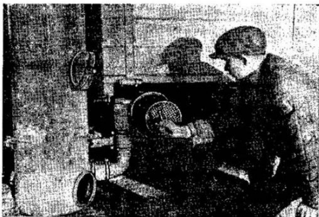
Фиг. 116. Выемка секций пластин очистителей для их очистки.
