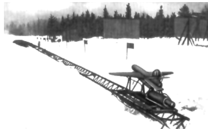
Рис. 65. Крылатая ракета 212 конструкции С.П. Королева, оснащенная гироскопической системой управления
