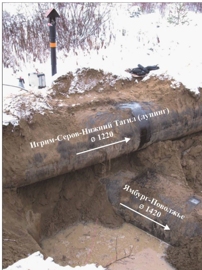
Рисунок 4.12. Пересечение магистральных газопроводов
