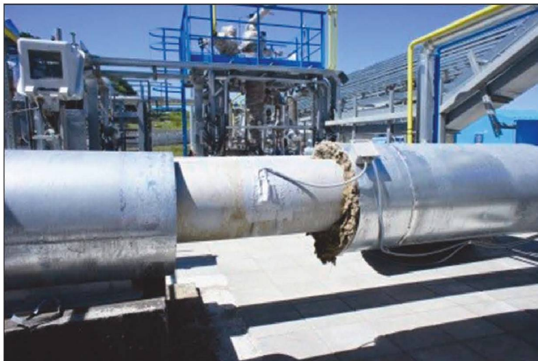
Рисунок 4.22. Датчики подсистемы мониторинга деформаций. Фотография выполнена в процессе монтажа
