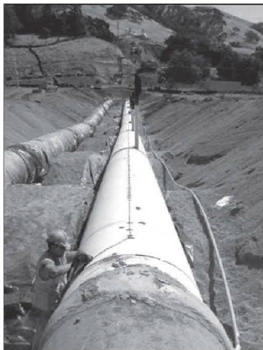
Рисунок 3.28. Процесс монтажа протяженного волоконно-оптического сенсора деформации
