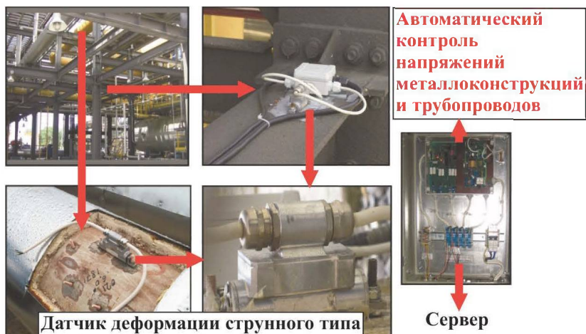
Рисунок 4.3. Подсистема мониторинга НДС
