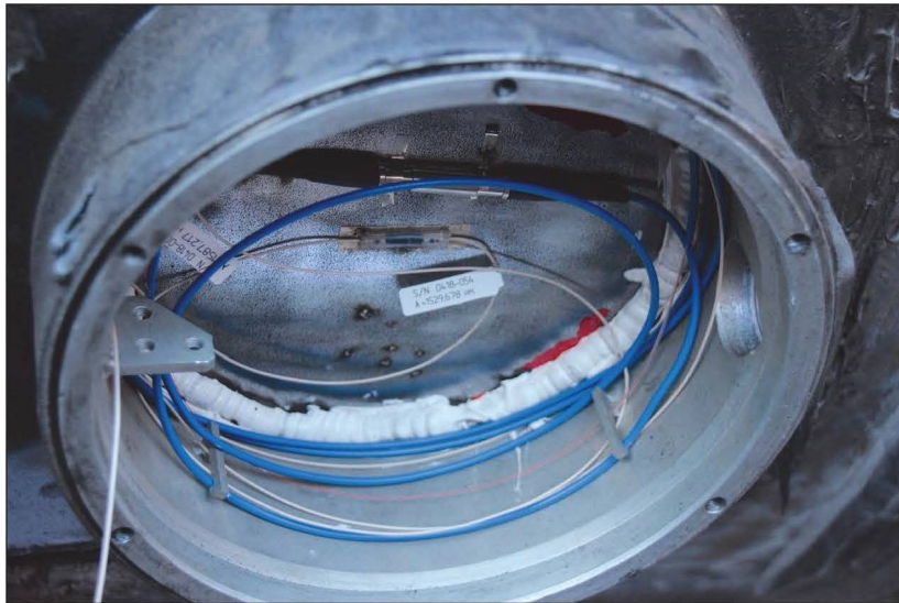
Рисунок 4.21. Датчики подсистемы контроля деформаций. Фотография выполнена в процессе монтажа
