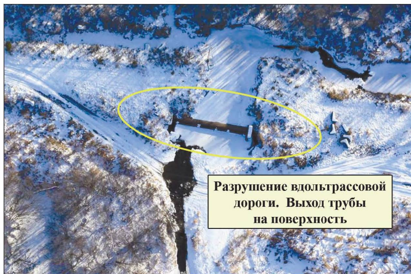
Рисунок 3.5. Аэрофотоснимок разрушения вдольтрассовой дороги и выхода трубопровода на поверхность [45]
