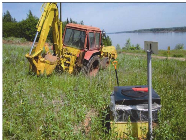
Рисунок 4.32. Установка герметических полипропиленовых бункеров на склоне
