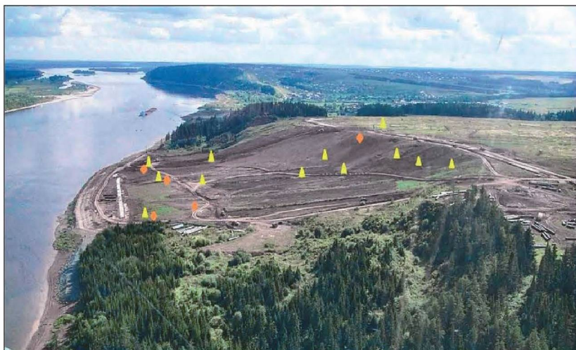
Рисунок 4.34. Оползневой склон подводного перехода МГ Ужгородского коридора через р. Кама с контрольными пунктами системы мониторинга:
