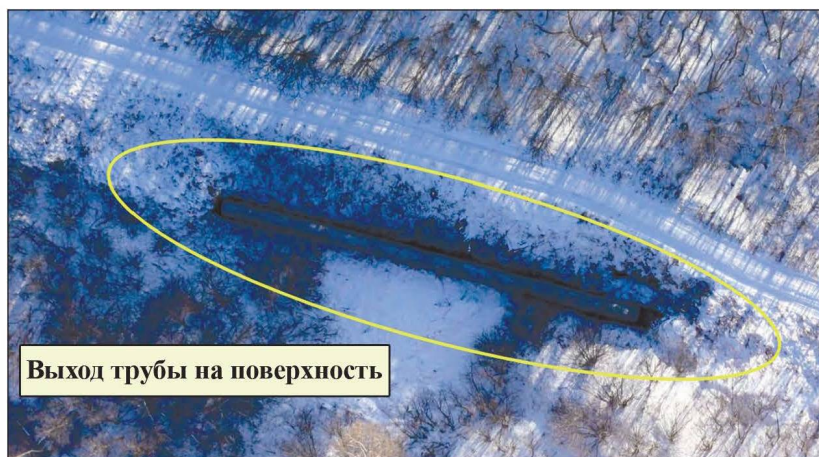
Рисунок 3.6. Аэрофотоснимок выхода трубопровода на поверхность [45]
