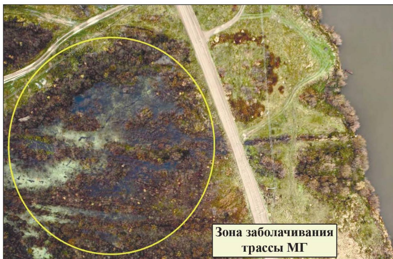
Рисунок 3.4. Аэрофотоснимок зоны заболачивания магистрального газопровода вблизи подводного перехода [45]
