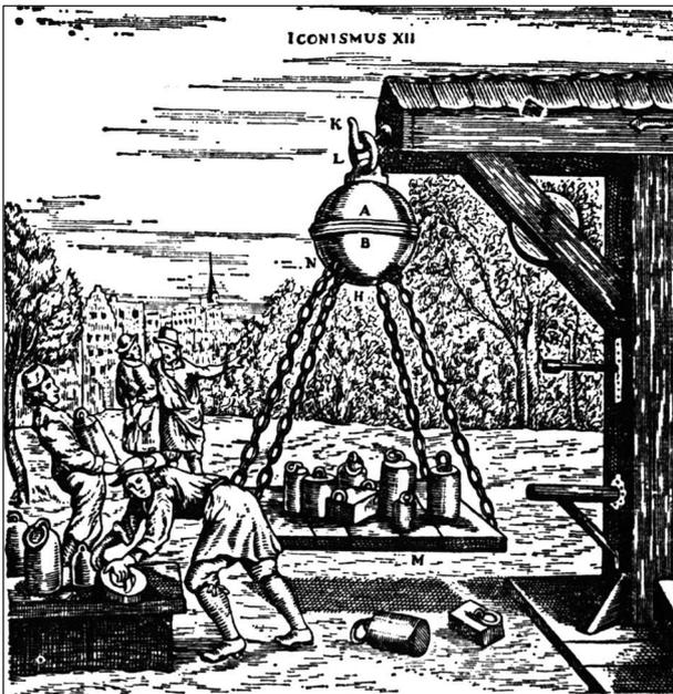
Рис. 278. Гравюра из книги Герике «Новые магдебургские опыты». Разрывание полушарий подвешенным грузом
