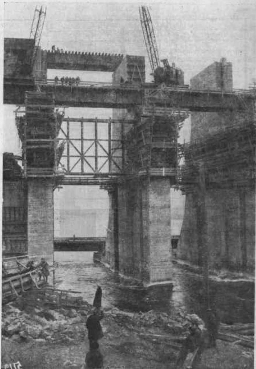
Рис. 62. Опуска- ние металличе- ского каркаса боль- шого щита греб- енки.
