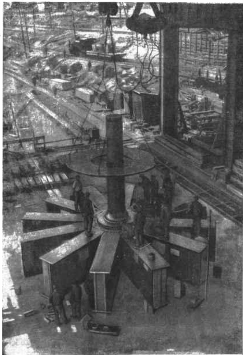
Рис. 24. Монтаж ротора генератора 77 500 ква.
