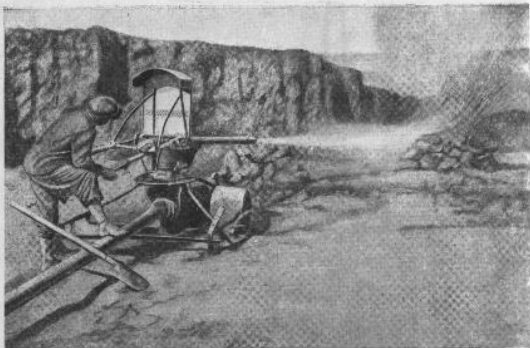
Рис. 84. Земляные работы в гавани. Гидромонитор.
