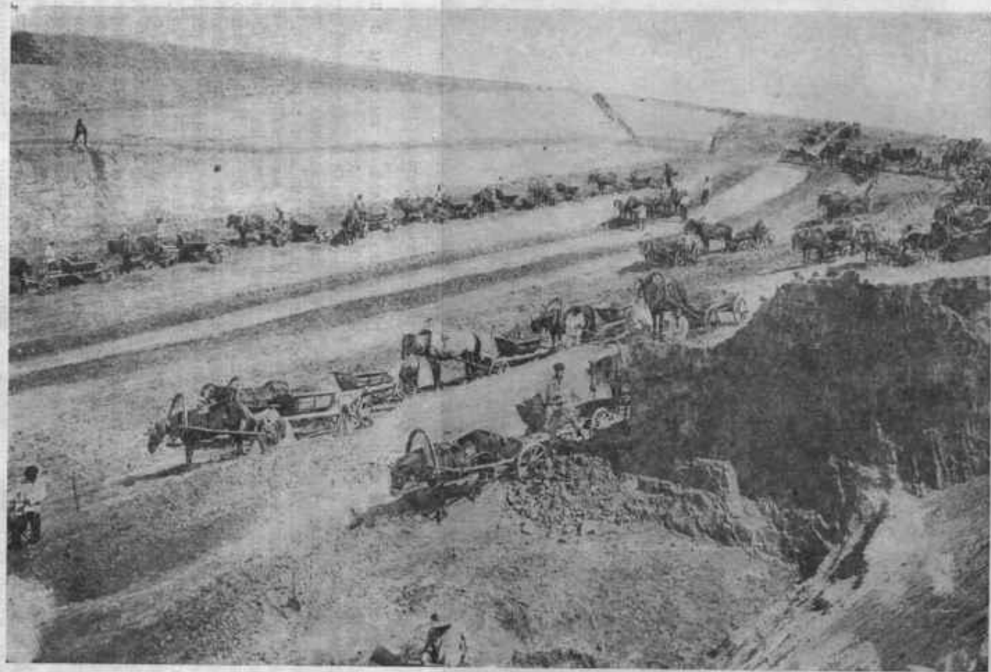
Гис. 68. Земляные работы в шлюзовой д. станиц. Август 1927 г.
