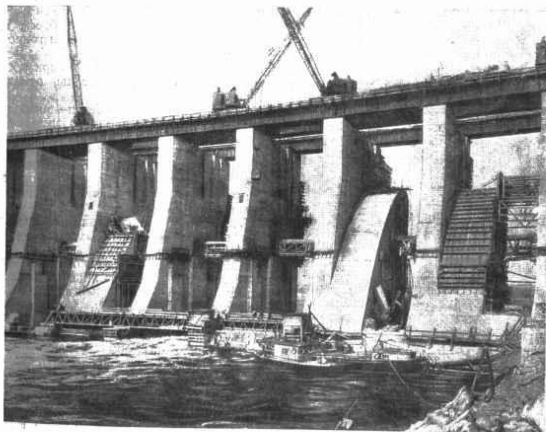
Рис. 11. «Гребенка» плотины. Работа по закрытию водосливных полуаркетов. Июль 1931 г.
