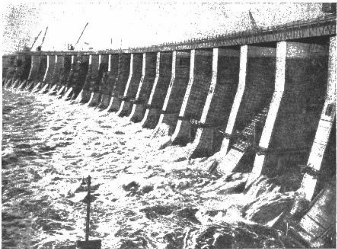
ростанцию в мае 1931 г. (паводок).
