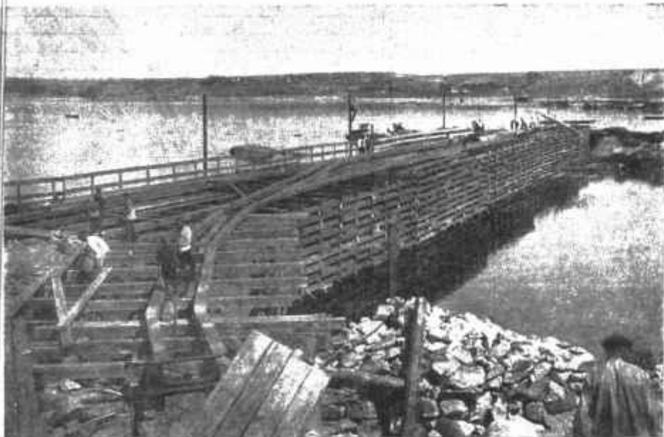
Рис. 46. Постройка ряжевых перемычек.
