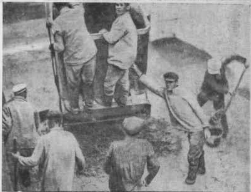
Рис. 78. Открывание бадьи с бетоном.
