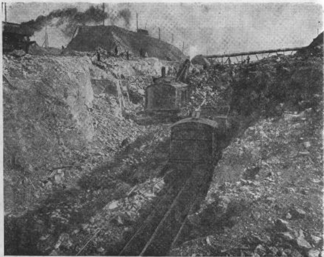
Рис. 69. Скальные работы в шлюзовой лестнице. Сентябрь 1928 г.
