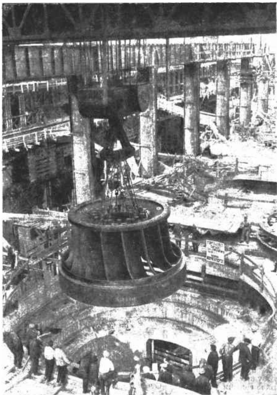
Рис. 21. Опуска- ние рабочего колеса турбины в спиральную камеру.
