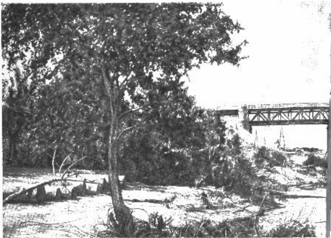
Рис. 31. Мост через р.
