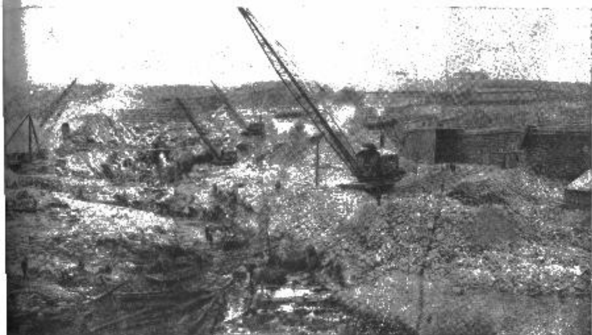
тины в котловане левого протока. Март 1929 г.
