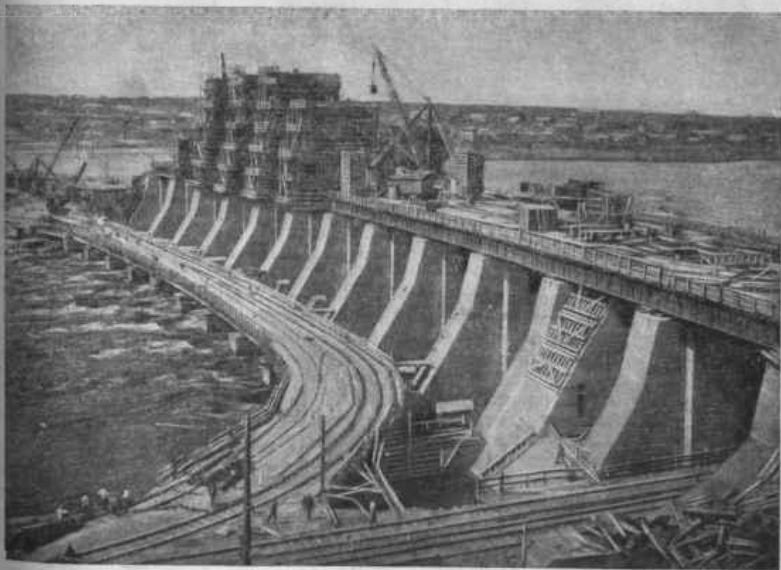
Рис. 58. Нарастивание бычков плотины катучими дерриками в левом протоке. Июль 1930 г.
