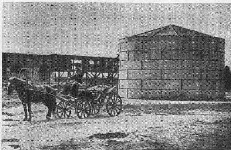
Один из первых шуховских резервуаров.
