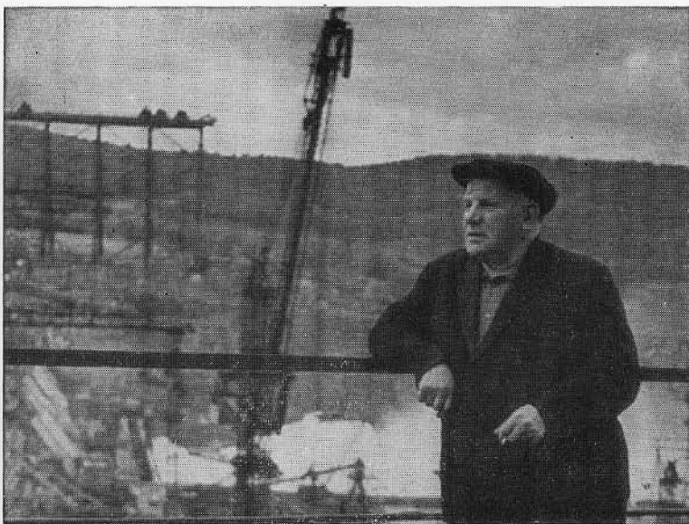
Иногда «Дед», иногда «Бог Енисея» — А. Е. Бочкин на строительстве Красноярской ГЭС.
