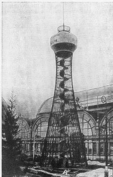
Водопроводная башня конструкции В. Г. Шухова в Нижнем Новгороде.
