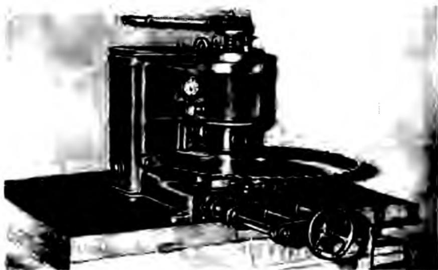
Рис. 45. Вальцовочный станок ПВ-20 с приспособлением для вальцевания дисковых пил
