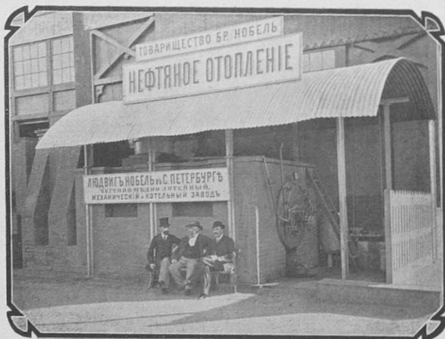
На Московской выставкѣ 1882 г. Котель, отопляемый нефтью.
