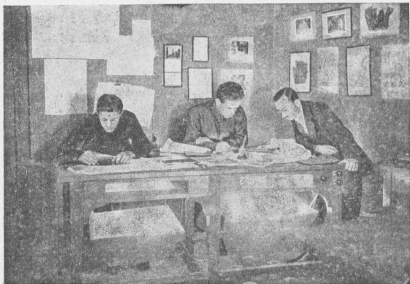
Рис. 13. Двойной монтажный стол, за которым два фотограмметриста монтируют трансформированные снимки в планшеты-фотопланы на геодезическую основу, сгущенную по мере необходимости: в поле — геодезически и набором фотограмметрических точек, в лаборатории — методом фотограмметрической сети (надир-триангуляция),
