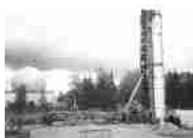
Рис. 3.22. Установка противоракеты А-925 в ШПУ [206]
