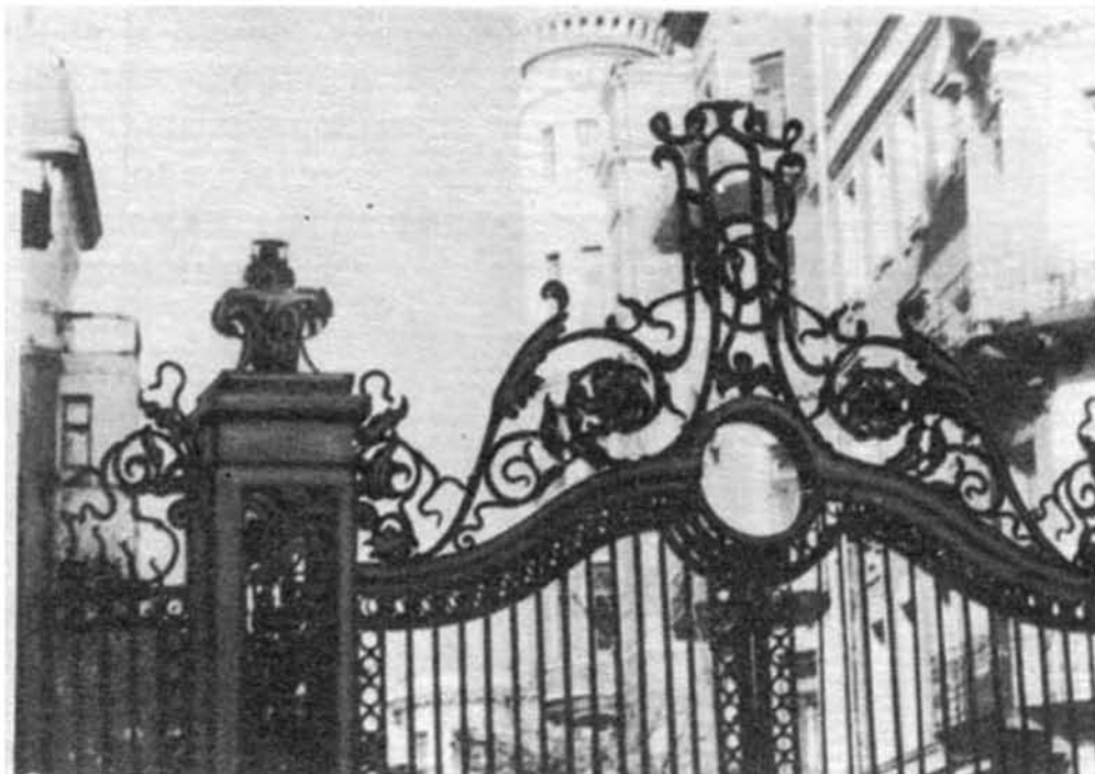
Рис 35 Ограда жилого дома
