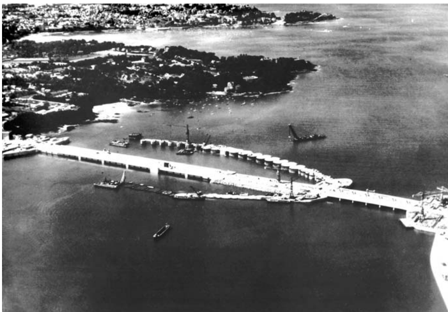
Рис. 12. Первая в мире приливная гидроэлектростанция на побережье Ла-Манша в бухте между городами Динан и Сен-Мало. Высота приливов здесь достигает 13,5 м. Сила приливов преобразуется в электричество 23 генераторами. Длина плотины электростанции — 350 м. (Фото ИТАР-ТАСС.)
