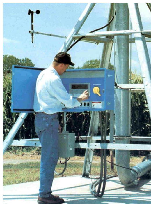
Рис. 2. Пульт управления работой низконапорной дождевальной машины «Valley»
